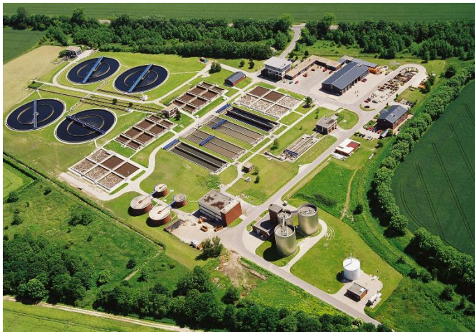
Bild 1: Zentrale Kläranlage Wilhelmshaven
