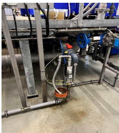
Bild 3: Zentratwassersonde FMC2
