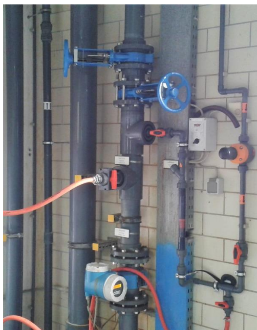
Eisen-III-Chlorid Dosierstelle
